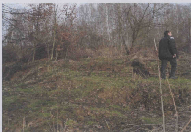
Fot. 5. Świeże skarpy wtórne w części aktywnej osuwiska.
