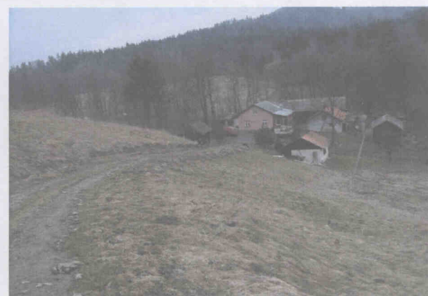
Fot. 6. Zachodnia skarpa boczna osuwiska oraz zabudowania posesji w m. Pietrusza Wola 10 poniżej.
