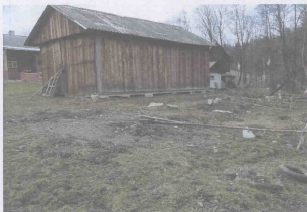
Fot. 3. Drewniany budynek gospodarczy na terenie posesji w m. Pietrusza Wola 10; poniżej zniekształcony przez osuwisko teren.
