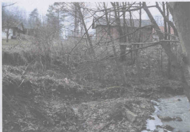
Fot. 2. Świeże skarpy wtórne nad potokiem; powyżej przeniesiony drewniany budynek gospodarczy zlokalizowany na terenie posesji w m. Pietrusza Wola 10.
