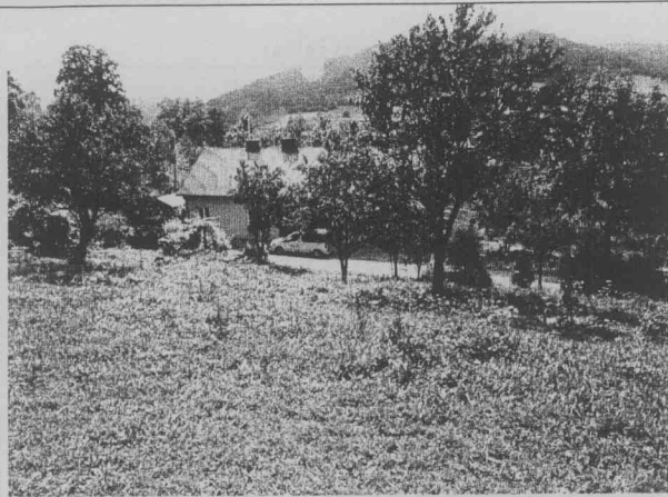
Ogólny widok na osuwisko z zabudowaniami mieszkalnymi
