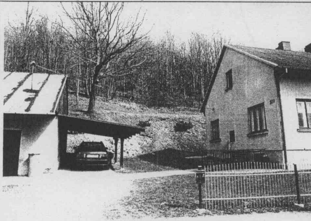
Budynek mieszkalny nr 200 oraz zabudowania gospodarcze
