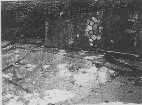
Widok na strefę osuwiska uruchomioną w lecie 2010 r. tworzącą nasunięcie w obrębie jezora osuwiska
