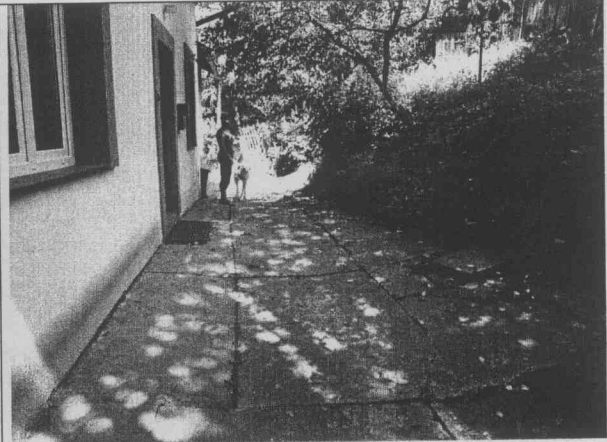
Jak obok, widok na budynek mieszkalny na działce nr 342 zagrożony przez uaktywnione osuwisko
