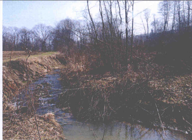
Widok na czoło jezora osuwiska przesuujące koryto potoku
