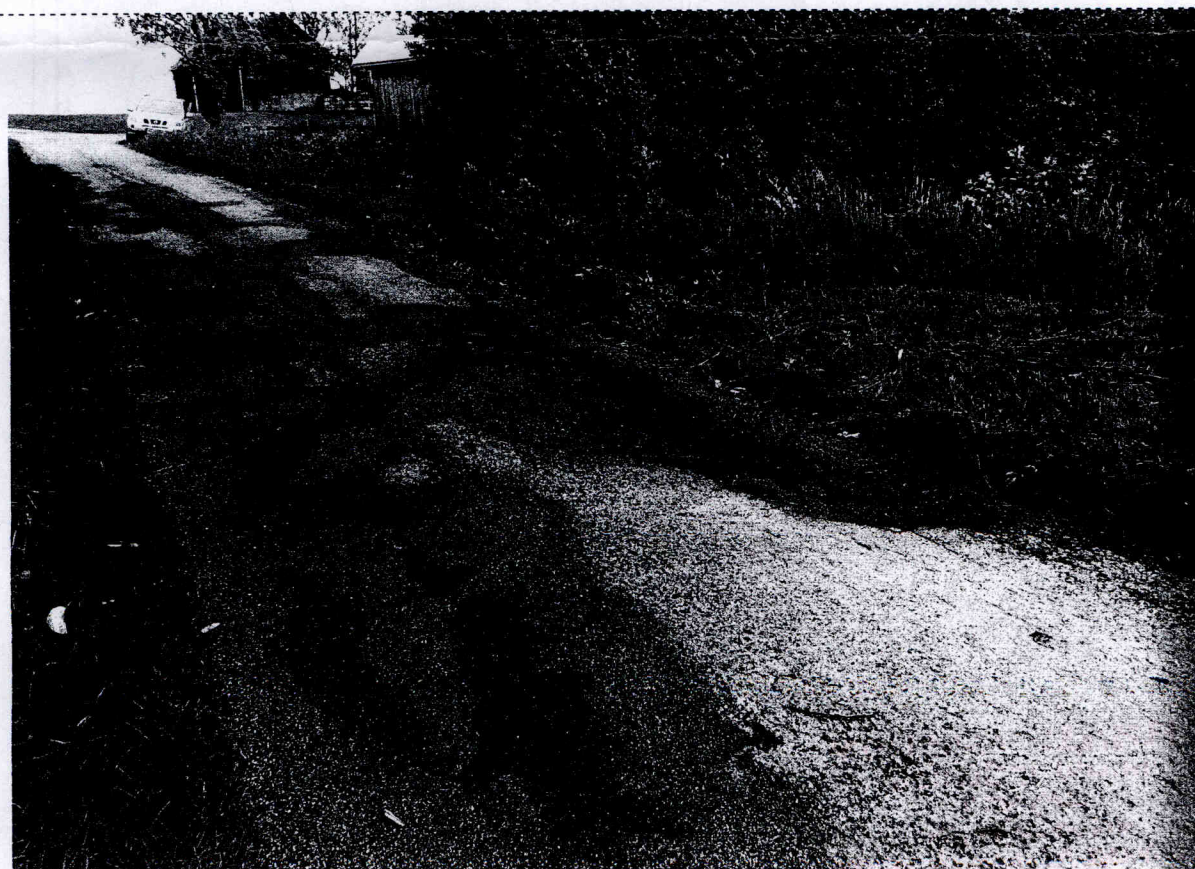
Aktywne osuwisko – widok na zniszczoną drogę
