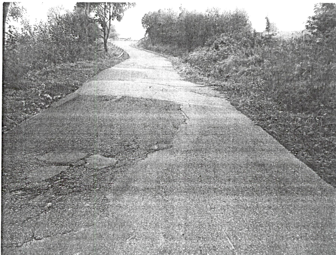
Fot. 2. Spękania drogi powiatowej w środkowej części osuwiska
